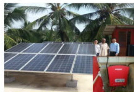
印度离岛发电站项目
