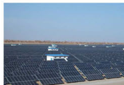
青海格尔木光伏电站
